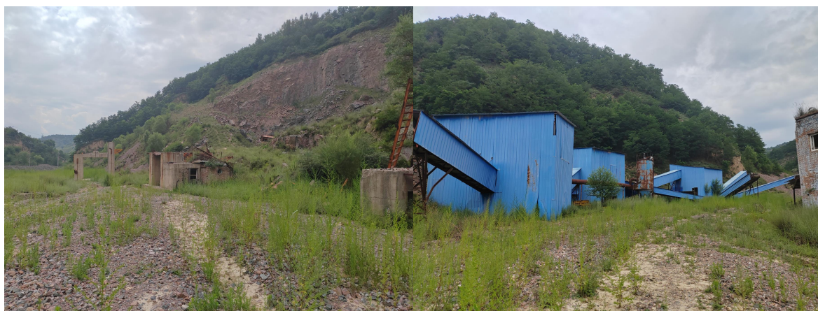
照片 8-2-3-5 原破碎筛分场地及堆料场
