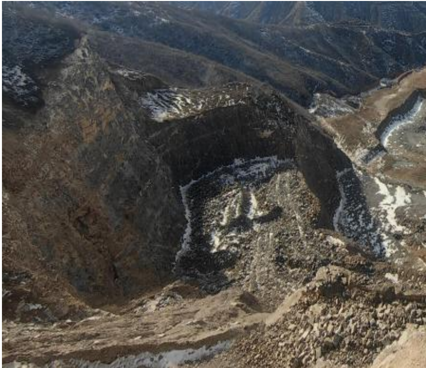
照片8-2-1-1 XP1不稳定边坡
