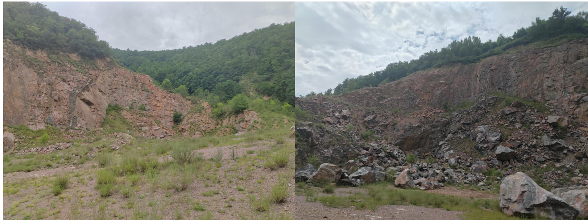
照片 8-2-3-2 露天采场石质基岩陡坡和废渣堆积边坡
