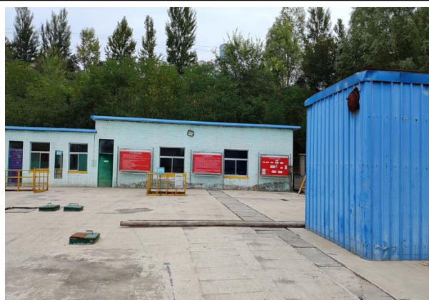
照片 8-2-10 生活污水处理站外观
