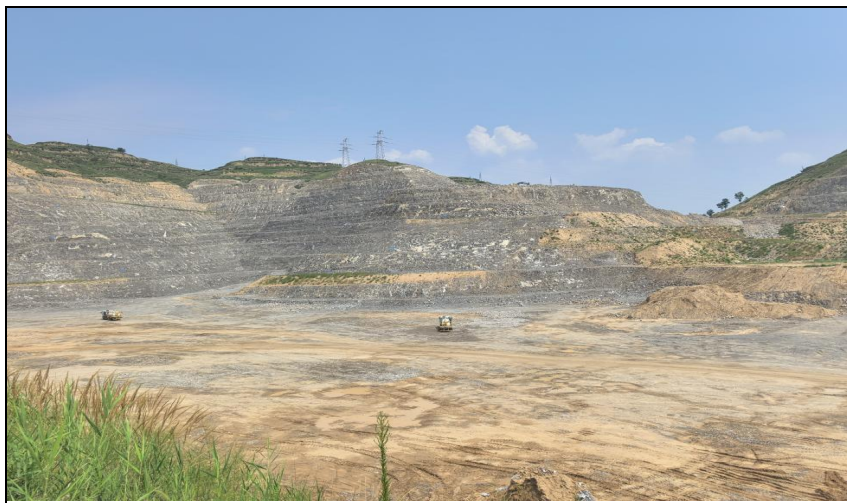
照片 8-2-1 露天采场北部边坡照片
