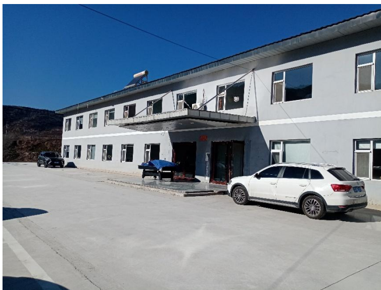
照片 8-6 工业场地办公楼（镜向西北）
