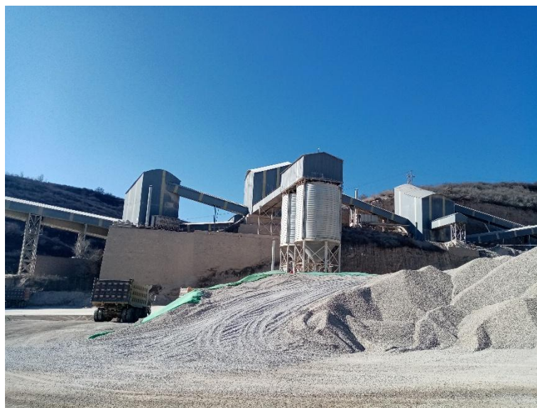
照片 8-9 破碎筛分场地
