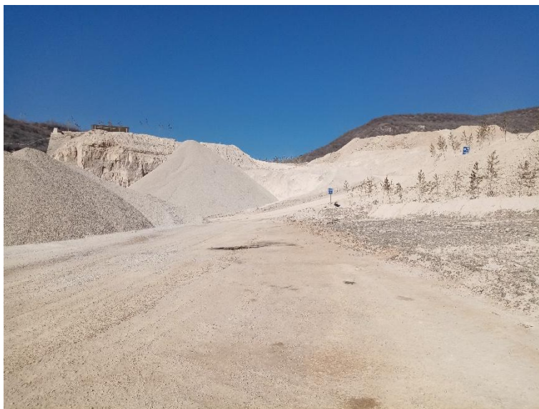
照片 8-10 矿区道路
