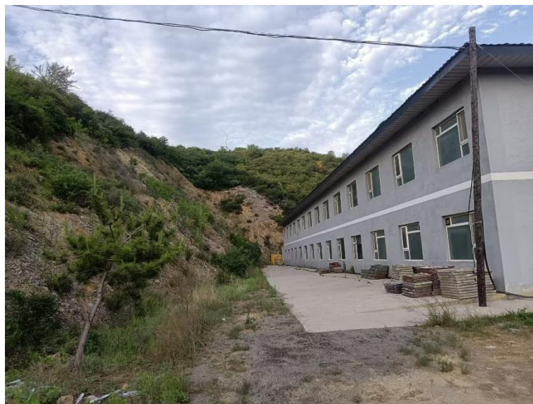
照片 2-2 工业场地北部挖方边坡 W1（镜向东）
