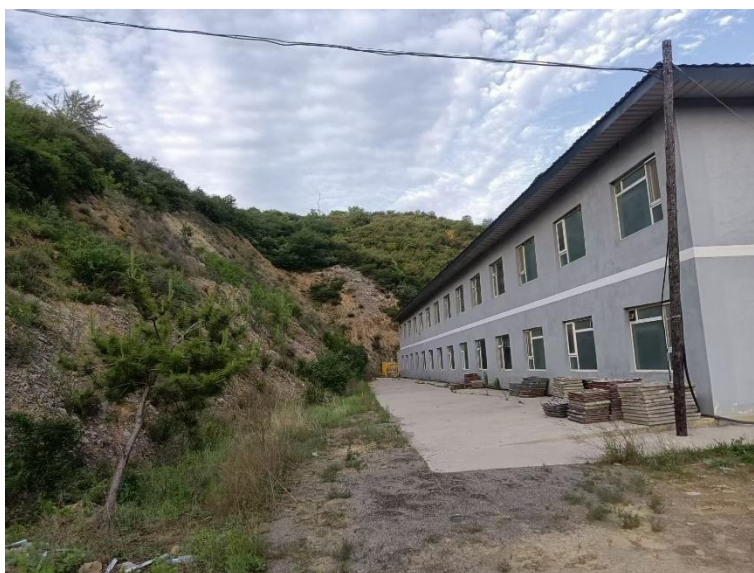
照片 8-2 工业场地北部挖方边坡 W1（镜向东）
