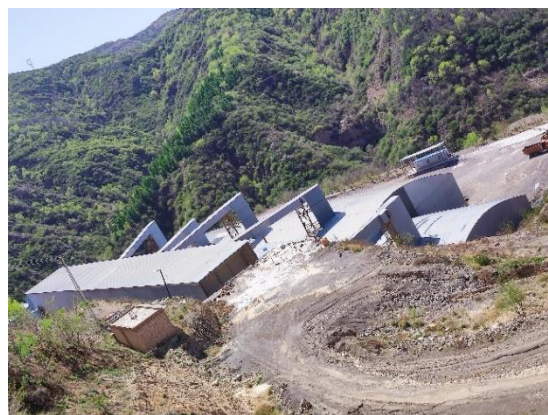
照片 8-6 露天采场挖损土地
