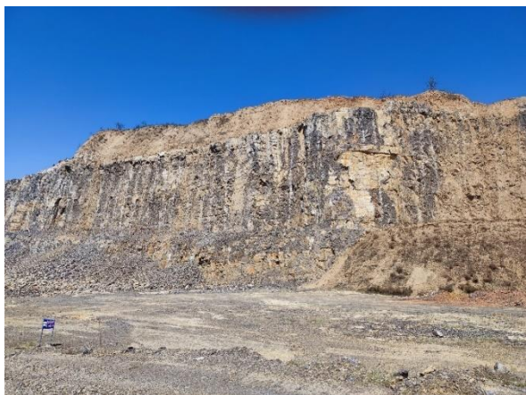
照片 8-1 XP1 边坡（镜向 NW）
