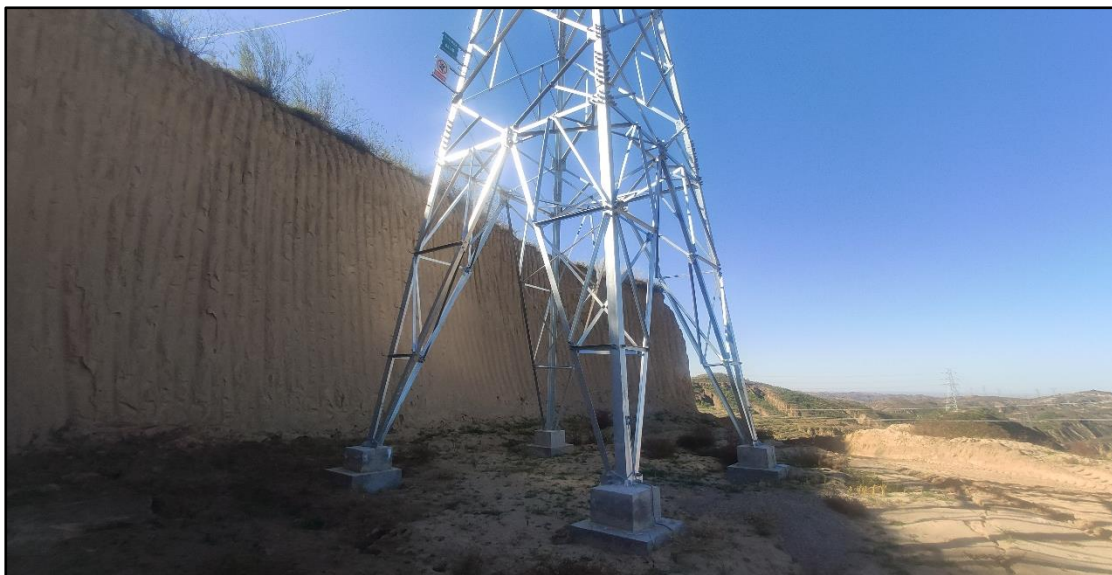
塔基区现状照片
