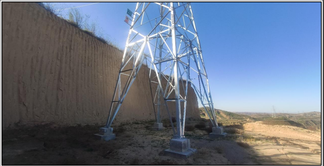
塔基区现状照片
