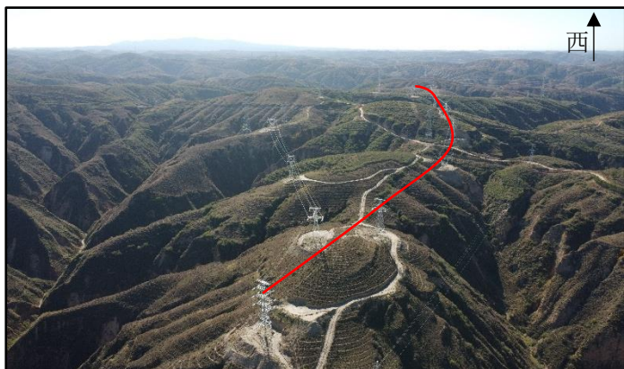
季家梁送出线路（与奥家湾项目分岔处）
