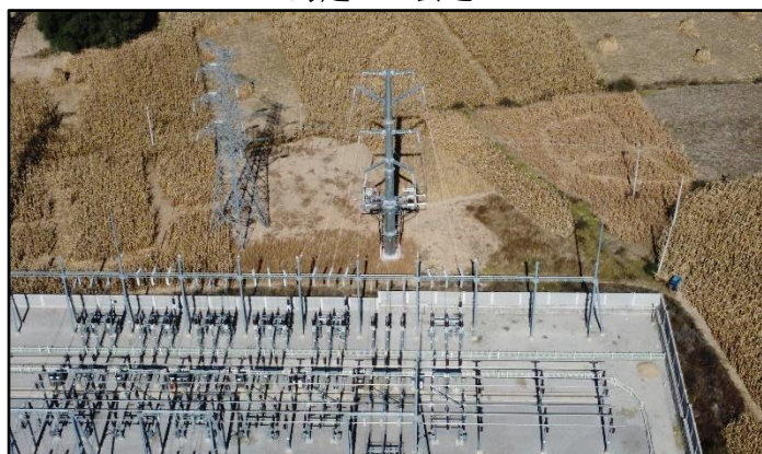
蔚汾变电站间隔扩建处
