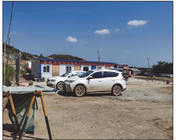
站内施工临时用房
