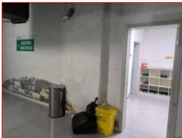
DSA 机房楼下洗衣房
