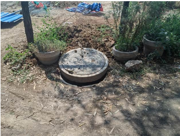
厂址北侧现有污水管网接口
