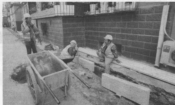
老旧小区改造中
