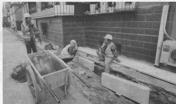
老旧小区改造中
