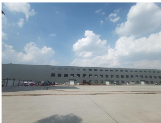
机修车间及综采设备库
