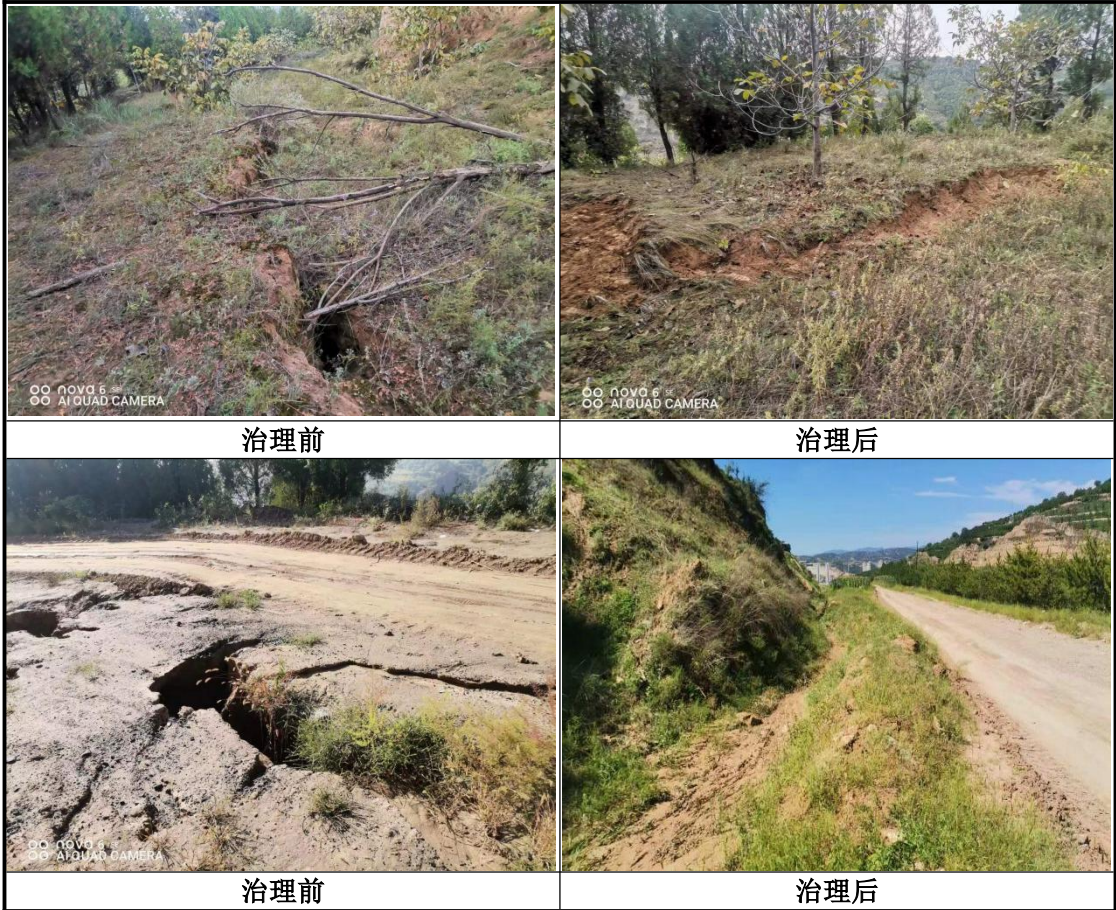
图 3-1-8 沉陷裂缝及治理效果图
