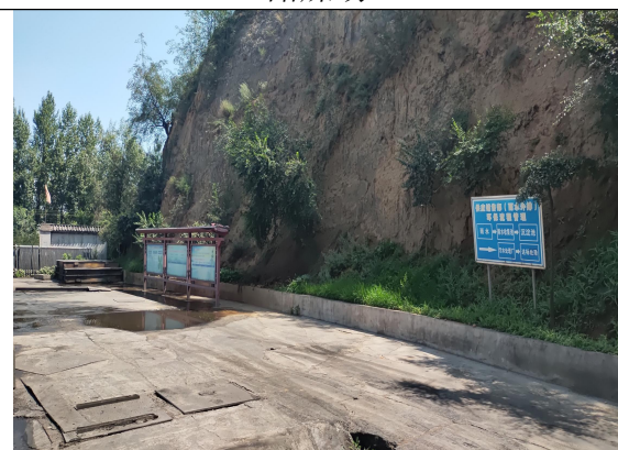
东部场地雨水收集池
