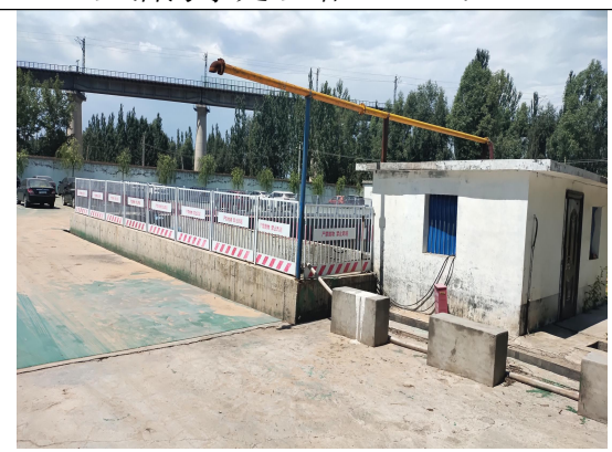
西部场地雨水收集池
