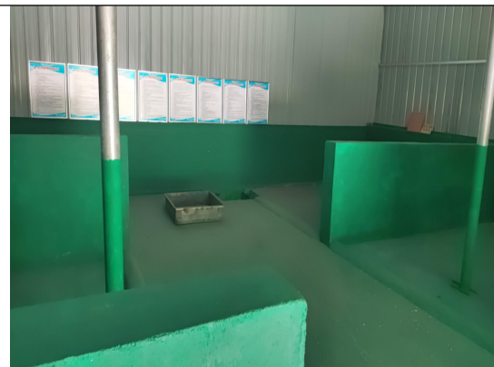
危废贮存库内部
