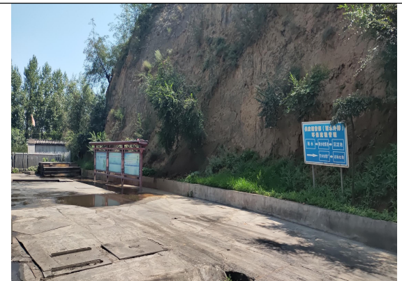
东部场地雨水收集池
