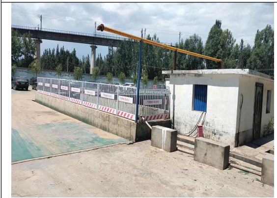
西部场地雨水收集池
