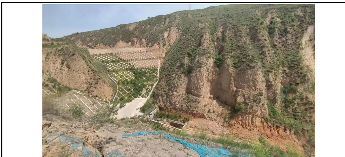
原有矸石场恢复情况
