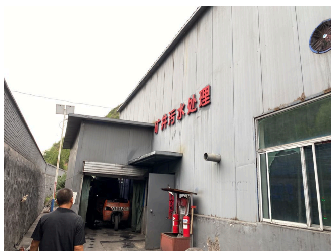
矿井水处理站
