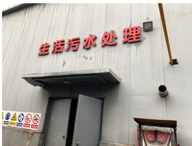
生活污水处理站
