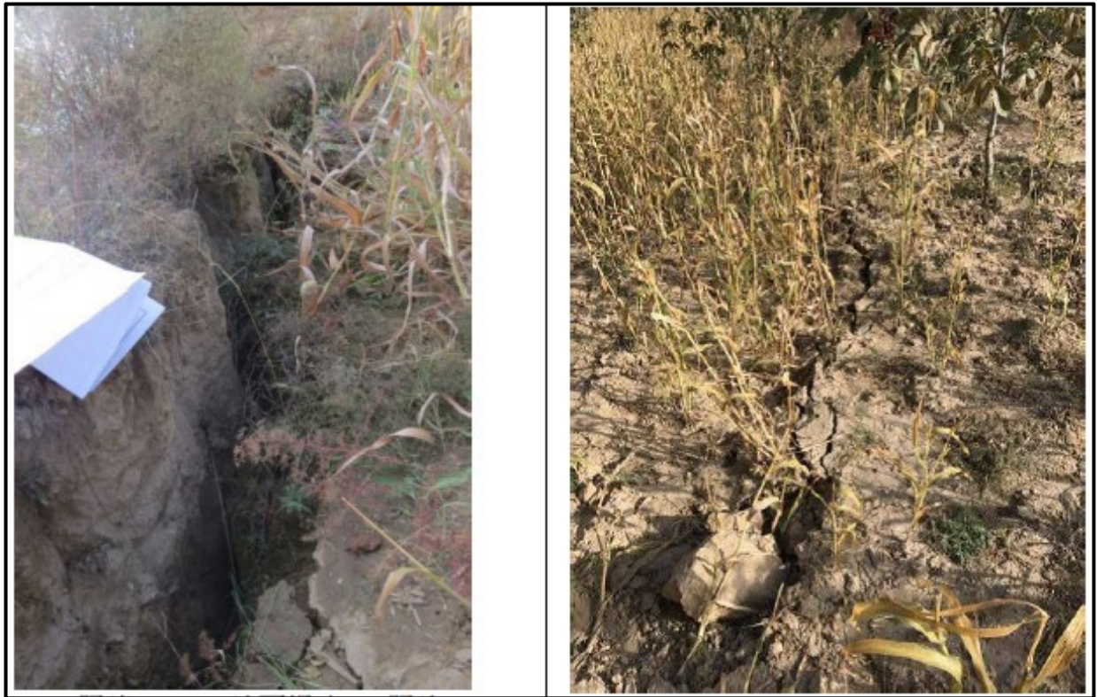
图 3.1-5 地表沉陷图片
