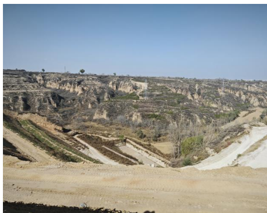
渗滤液收集池
