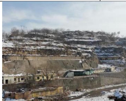
风井场地台阶状边坡
