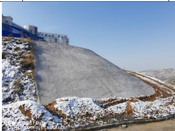
工业广场护坡
