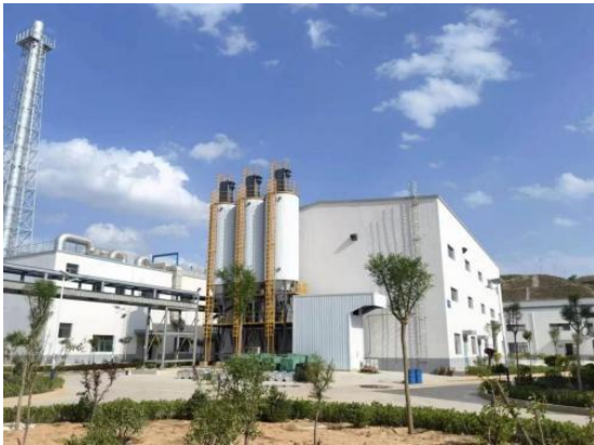
现有稳定化车间
