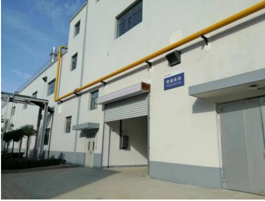
现有焚烧车间
