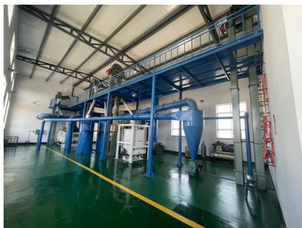
原料破碎车间二层
