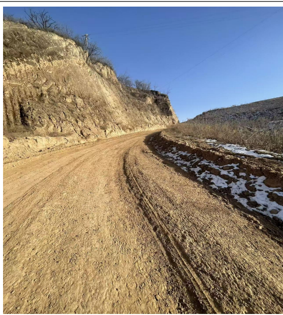
华泰洗煤厂配套田家坡矸石场运矸道路
