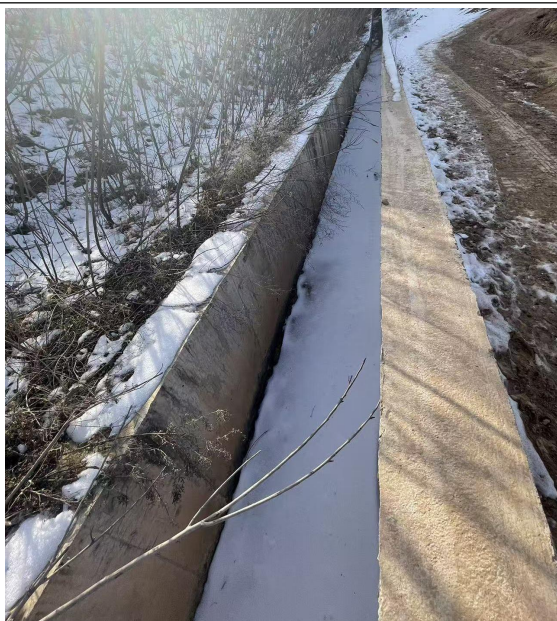
华泰洗煤厂配套田家坡矸石场现有截洪沟
