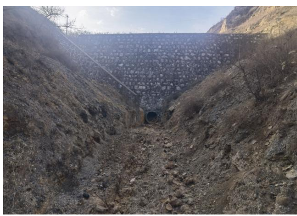
华泰洗煤厂配套田家坡矸石场现有拦矸坝
