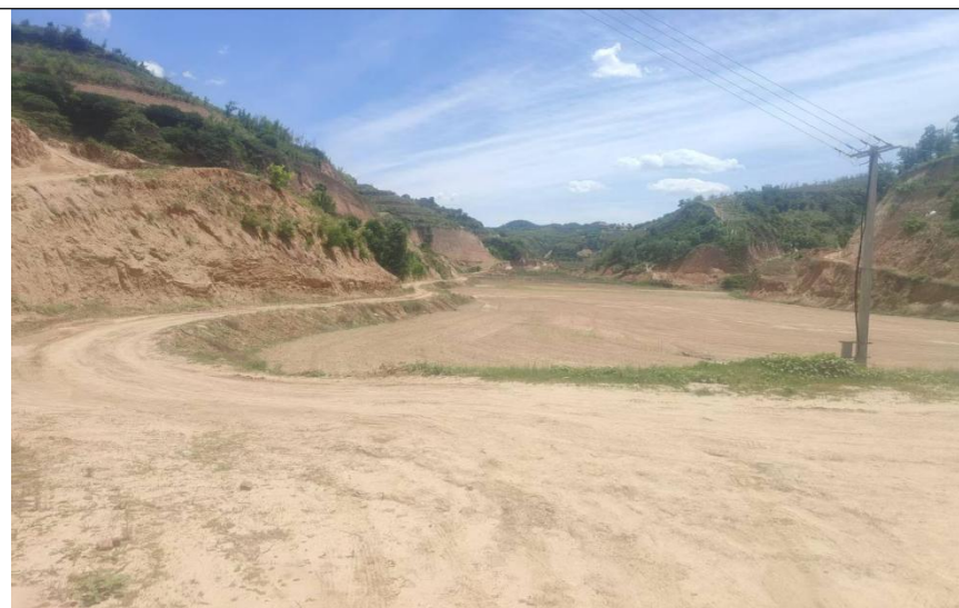
养殖场（场地一）东南侧及进出道路区现状
