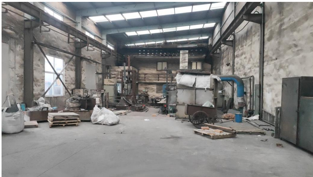
生产车间内部北侧（原为锰铁成品库内氮化锰试验区）
