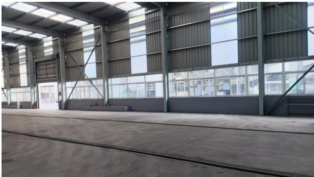
生产车间内部南侧闲置部分（原为锰铁成品库）
