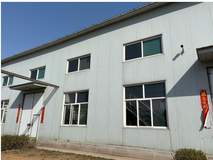
餐厨废弃物处理车间
