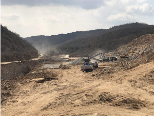
照片 1-2 整平场地（镜向南）
