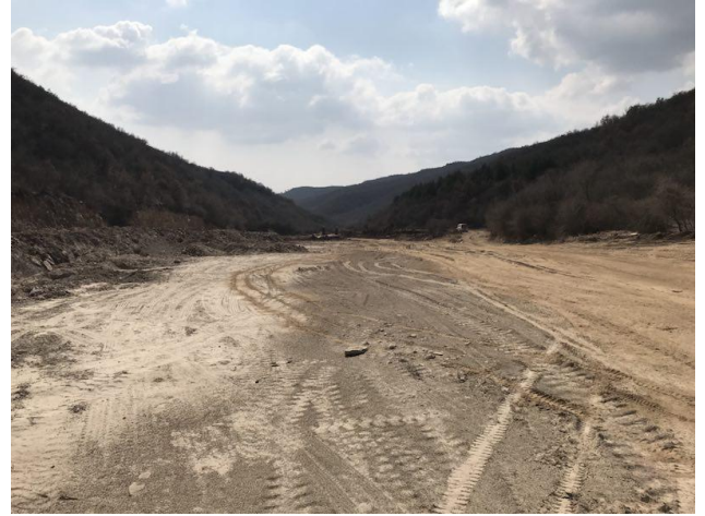
照片 1-6 整平场地（镜向南）
