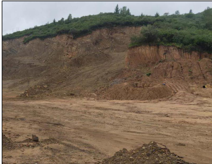
照片8-1 边坡WP1（镜向西）
