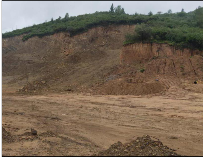
照片8-1 边坡WP1（镜向西）
