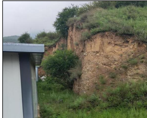
照片8-3 边坡WP2（镜向西）
