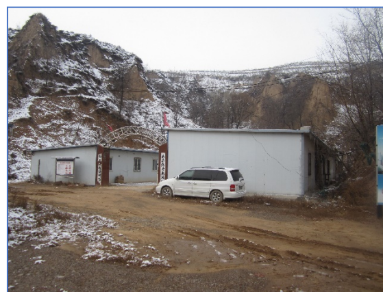
照片 8-2-4 原办公区现状(镜向 W)
