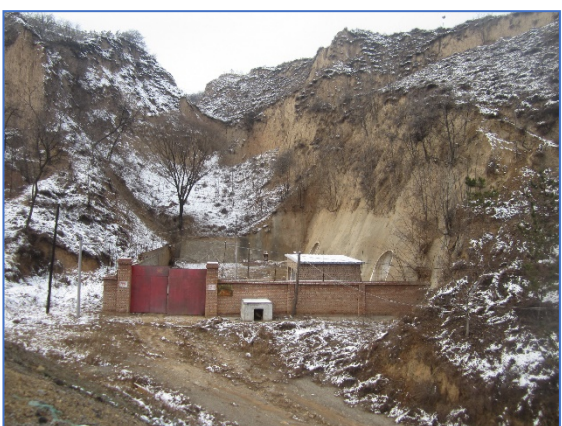
照片 8-2-15 炸药库周侧边坡(镜向 ES)
