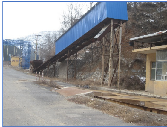
照片 8-2-8 XP3 已治理边坡(镜向 WS)
