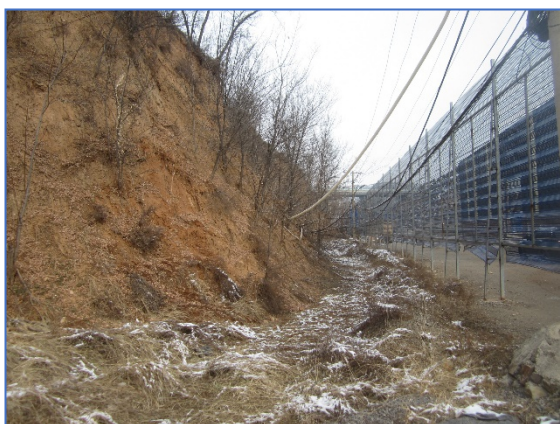
照片 8-2-7 XP2 已治理边坡(镜向 NE)
