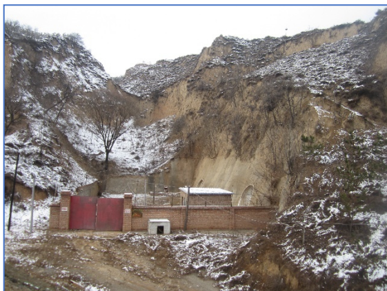
照片 8-2-5 XP1 已治理边坡(镜向 WN)
