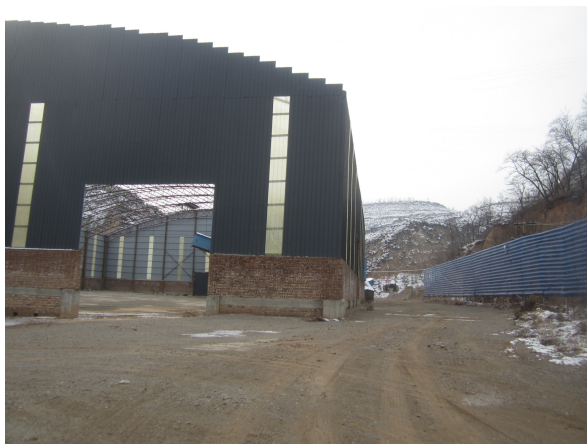
照片 8-2-34 封闭式储料棚
