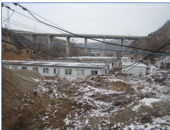
照片 8-2-16 W2 不稳定边坡北(镜向 ES)
