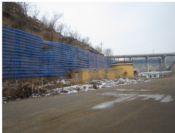
照片 8-2-35 北侧防风抑尘网
