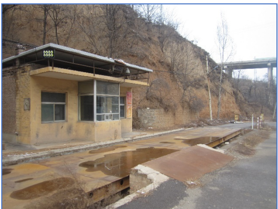
照片 8-2-13 磅秤房北边坡(镜向 N)
