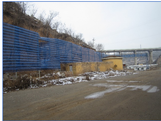
照片 8-2-6 XP2 已治理边坡(镜向 N)
