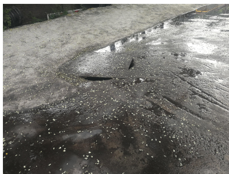
主井工业场地初期雨水收集池
