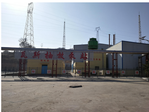
瓦斯抽放泵站
