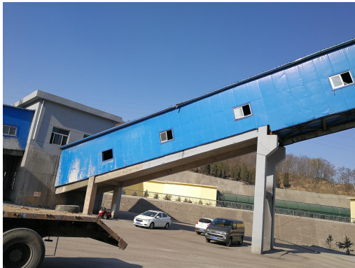
皮带封闭走廊
