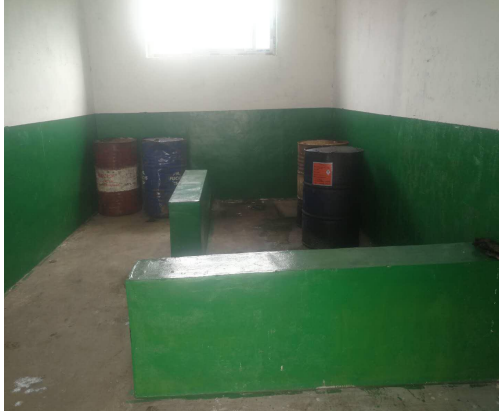
危废暂存间内围堰
