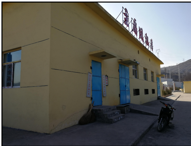
风机房建筑隔声
