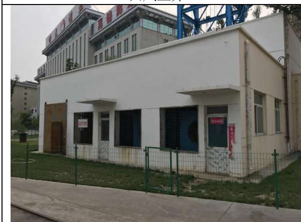
副井空气加热室
