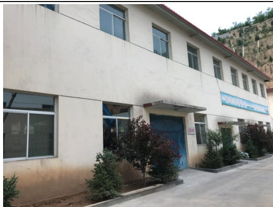
空压机室内布置
