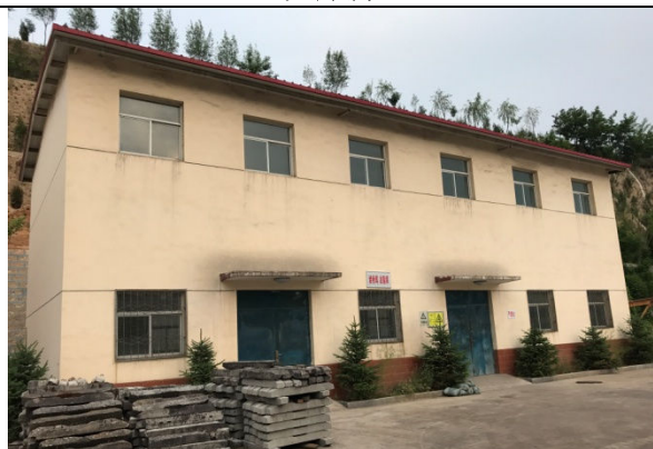
岩粉库、油脂库
