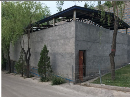
风机平台封闭
