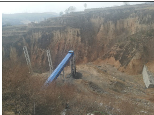
排矸皮带走廊
