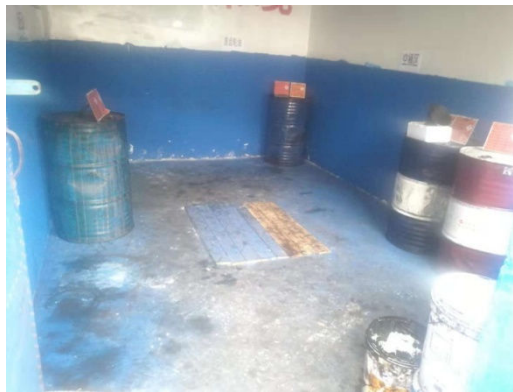
地面及裙角环氧地坪漆防渗
